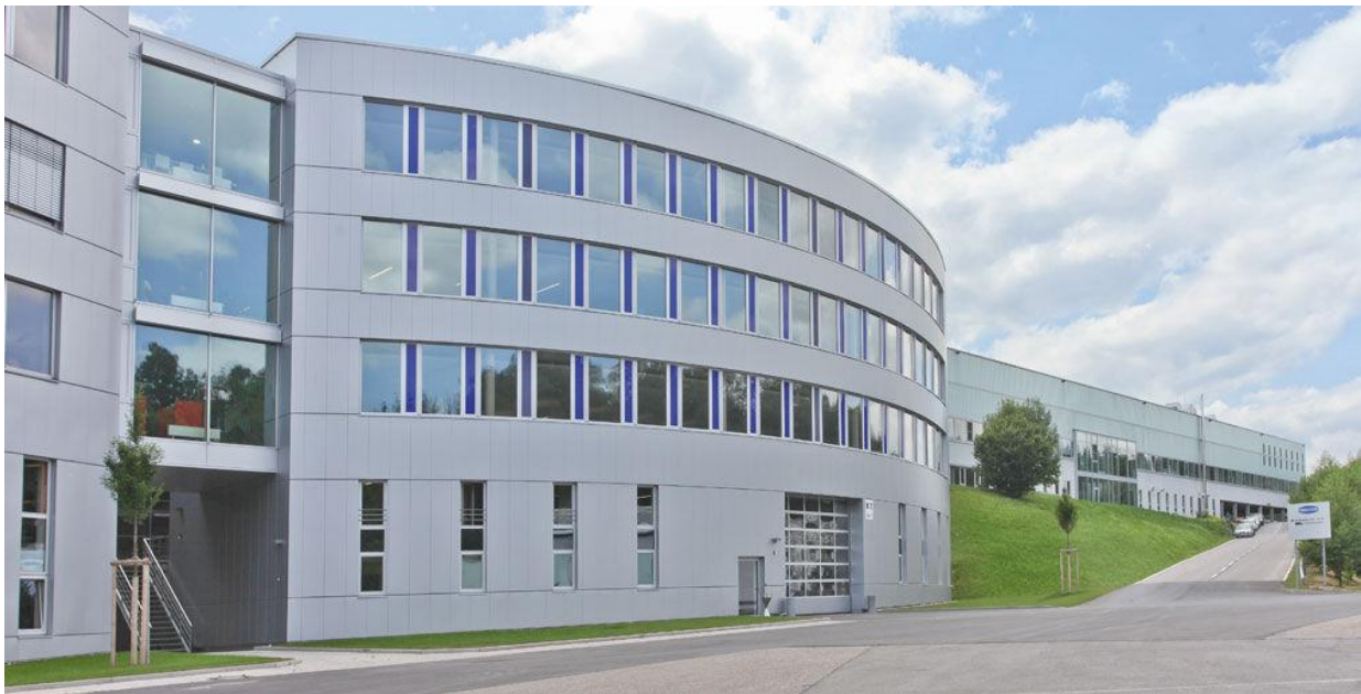
J. Schmalz GmbH in Glatten, Quelle Schmalz
