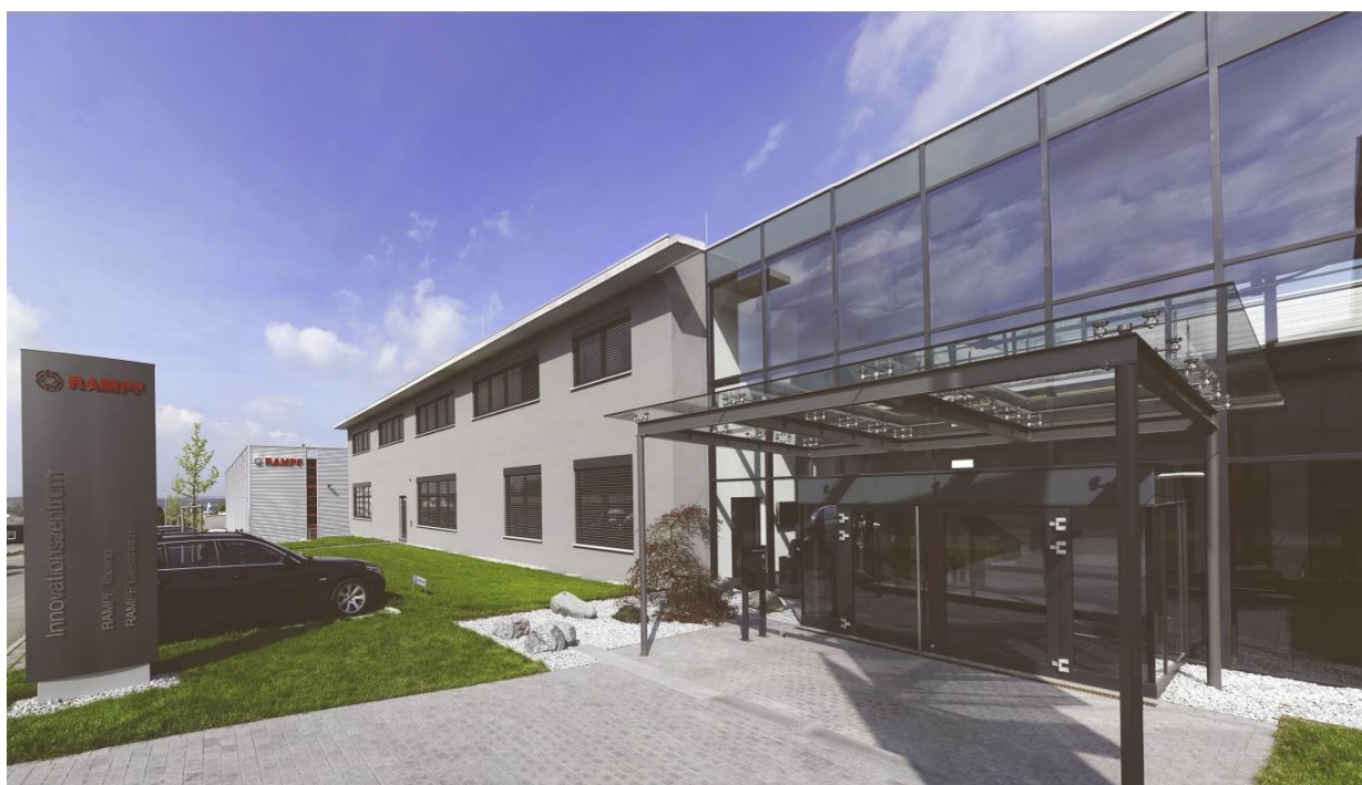
Rampf Innovationszentrum Grafenberg, Quelle Rampf
