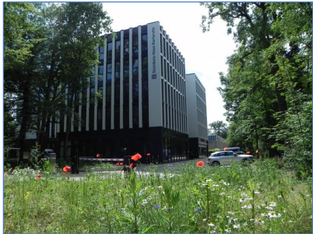
Abb. 7: Steinbeis-Haus in Karlsruhe
