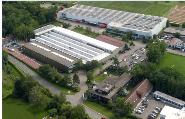
Abb. 3: Sitz der Keller Lufttechnik GmbH + Co. KG in Kirchheim unter Teck
